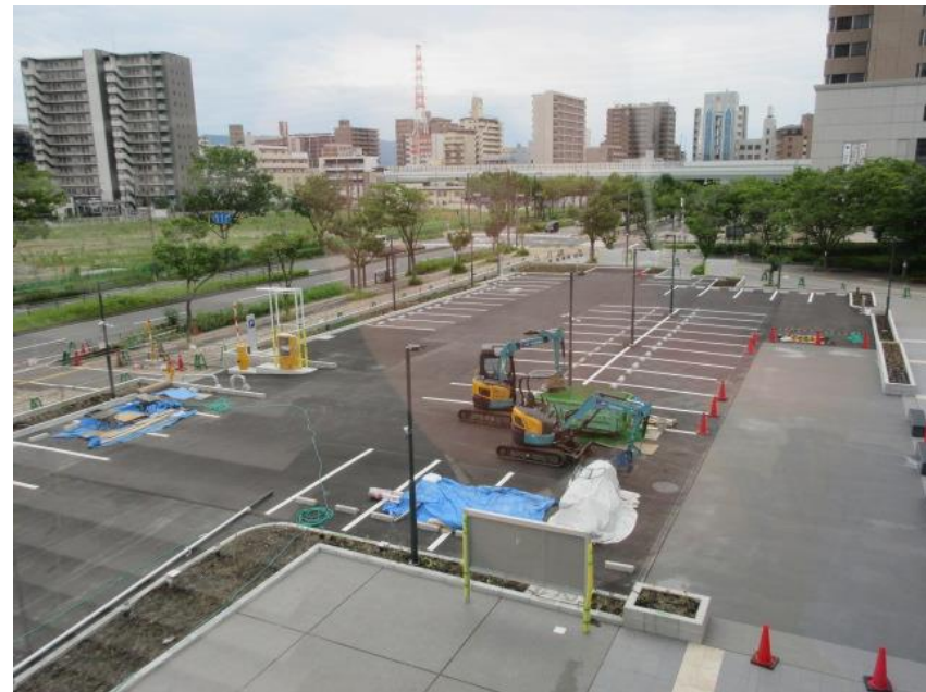
平面駐車場（工事中）・・・本年8月より利用開始
