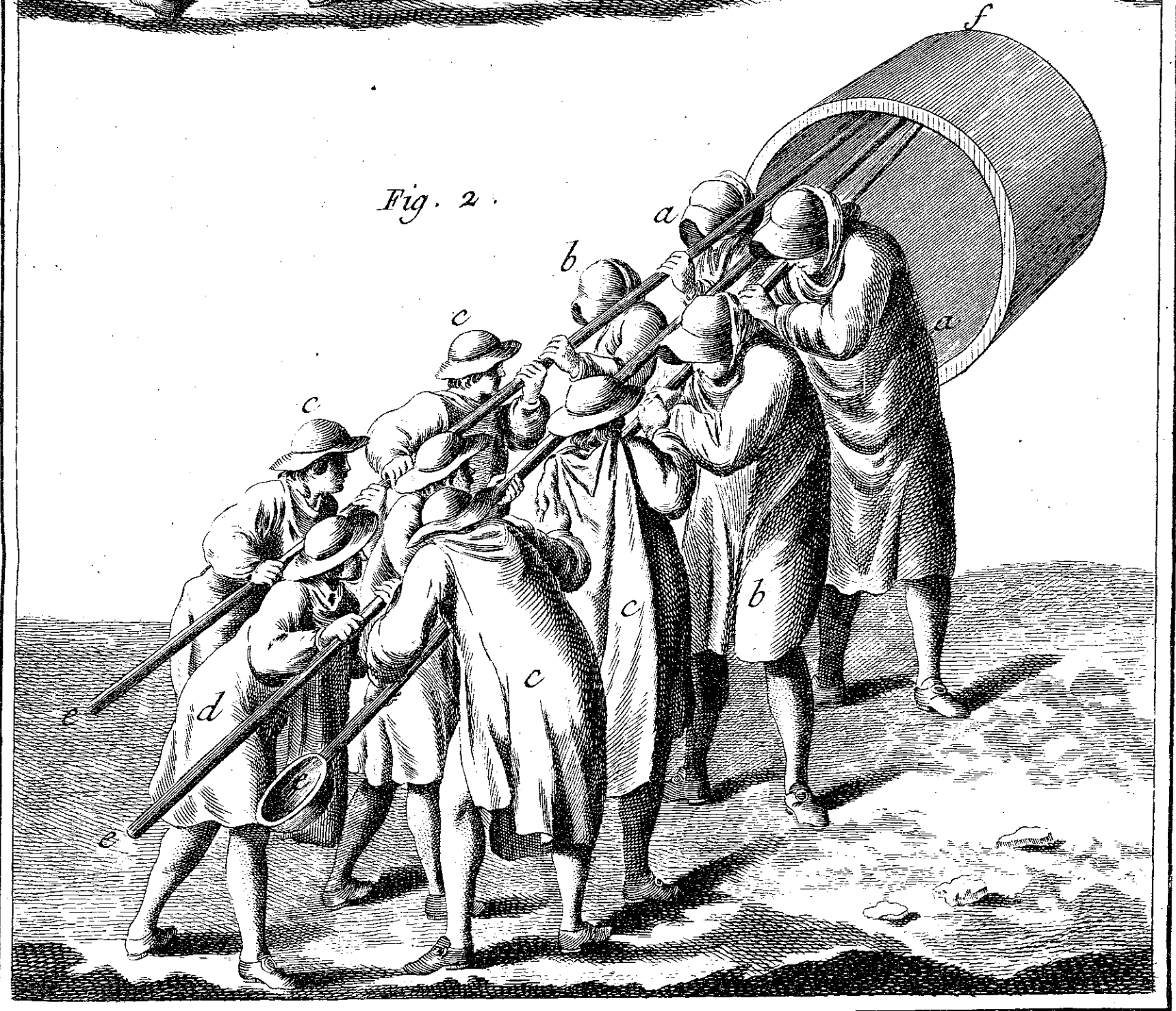
Verrerie en bois, l'opération de tirer le Pot hors de l'Arche, et l'opération de le porter au Four.
