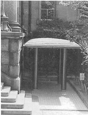
利用者用入口改修（昭和63年）
